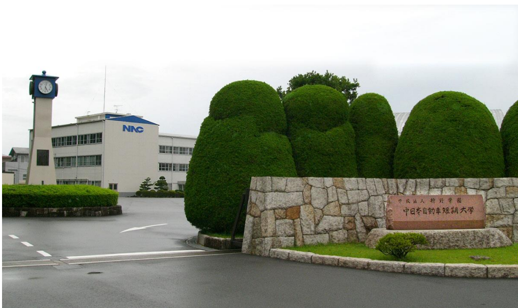
写真：正門付近
