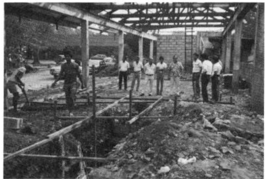
車検場建設風景
