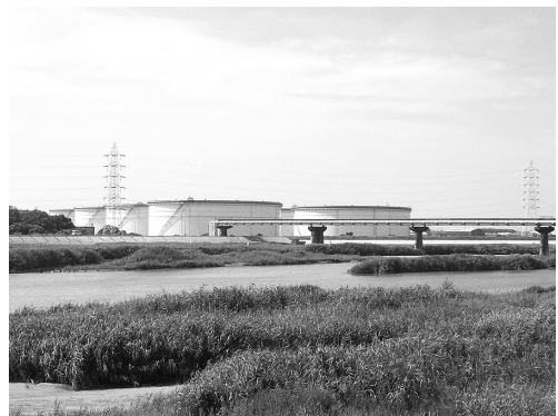
図8 原油タンク施設
