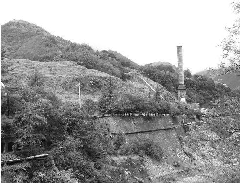
図13 足尾本山製錬所跡
